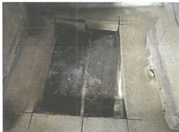
Aus dieser Estrichplatte wurden Prüfkörper entnommen und die Biegezugfestigkeit (Bauteilprüfung) in Anlehnung an die ÖN B 3732 bestimmt. Dabei wurde die „Biegezugfestigkeit“ mit der maximal aufgebrachten Bruchlast analog eines unbewehrten Estrichs errechnet.
